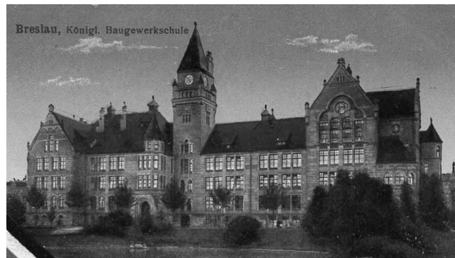
Rys. 4. Secesyjny budynek po dawnej Inżynierskiej Szkole Budownictwa, obecnie Wydział Architektury [7]
