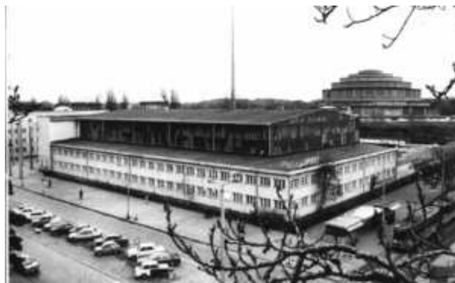
Rys. 7. Budynek Instytutu Automatyki Systemów Energetycznych IASE przy ul. Wystawowej 1
