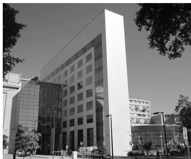
Rys. 8. Budynek D-20 przy ul. Janiszewskiego 8; z prawej widoczna sala kongresowa
